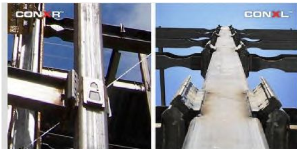
در نوع اتصال صلب ارائه شده توسط ConXtech
