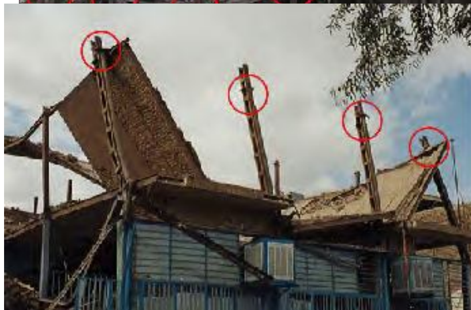
شکل 1) شکست اتصال خورجيني در اثر
